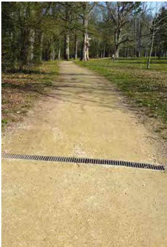
SYSTÈME D'ÉVACUATION PLUVIALE SUR CHEMINEMENT DE PARC EN STABILISÉ.
