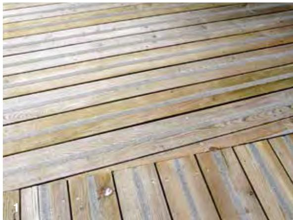
1- APERÇU DÉTAILLÉ DE PLATELAGE, AVEC SYSTÈME ANTIDÉRAPANT.
