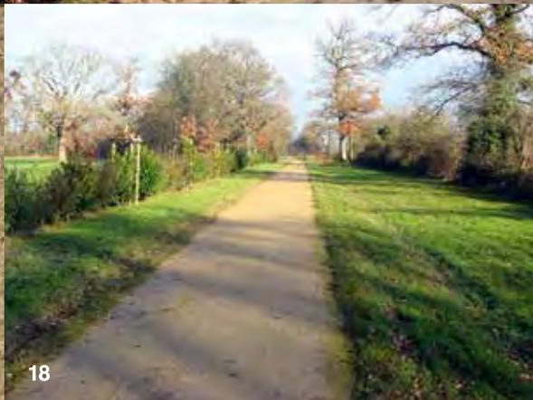
13- DÉTAIL STABILISÉ DE TYPE STARMINE (À SURFACE RELATIVEMENT FERMÉE).
