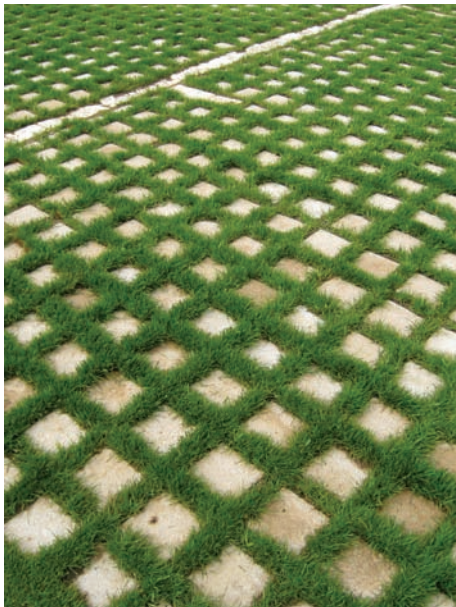
Exemples de traitements de sols non imperméables : pavés joints gazon - sols minéraux stabilisés ou compactés - gazon renforcé - concassé calcaire colonisé par de la végétation (lichens, mousses, sédums ...)
