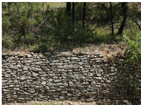
► Soutènement en petits moellons assisés au Montat (46)
