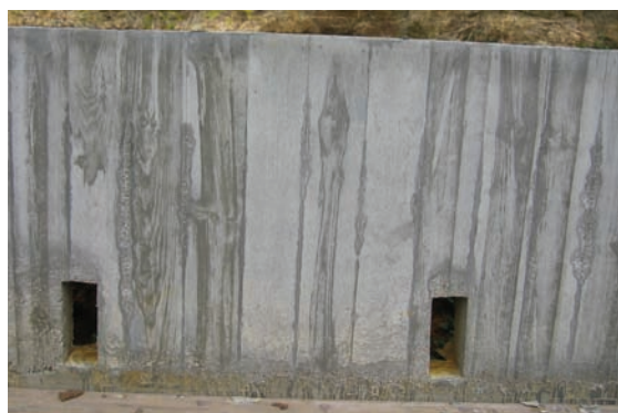
► Soutènement réalisé en béton au Vigan (46) - M. Favresse architecte
