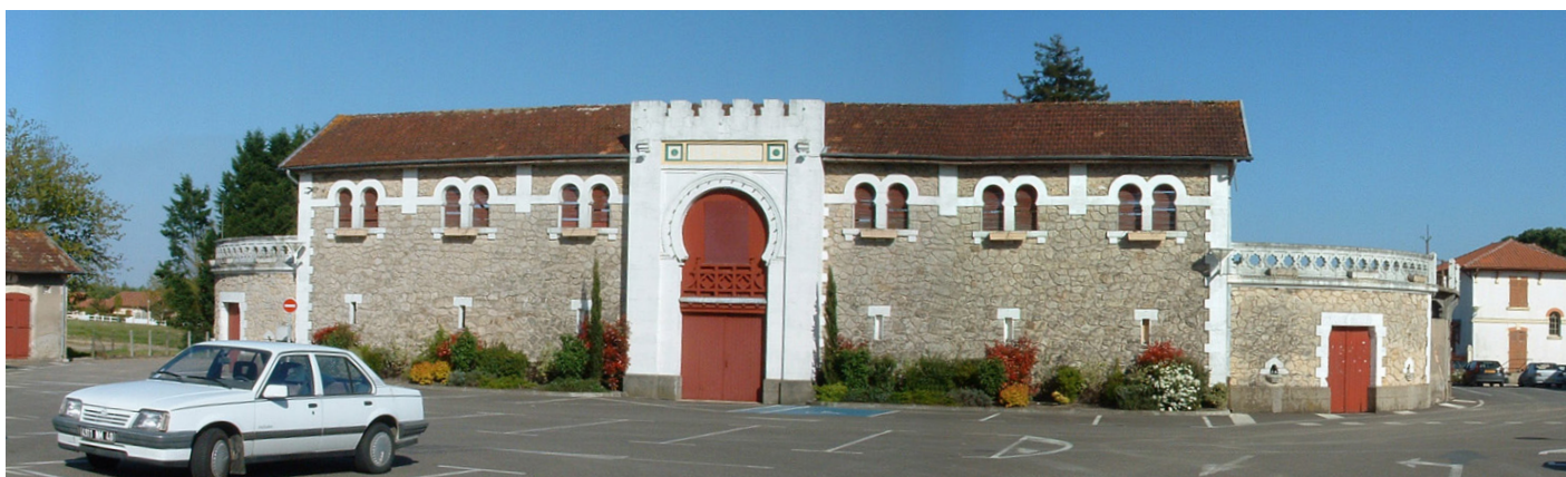
▲ Avant : entrée principale
